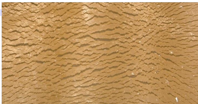
Abb. 10: Flächige Risse infolge chemischen Angriffs (Vergrößerung 30-fach, Probe leicht gedehnt, daher trotzdem mit leichter Orientierung)
